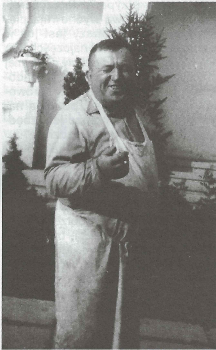
Ks. St. Bochenek przy budowie kościoła
