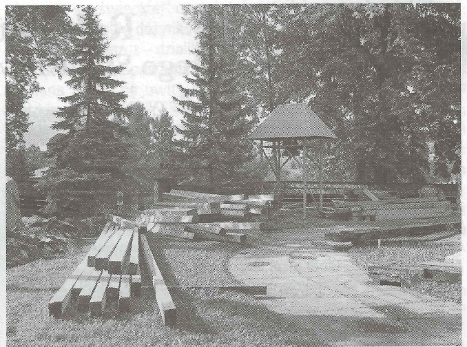
We wrześniu przystąpiono do odbudowy spalonej wieży kościelnej
