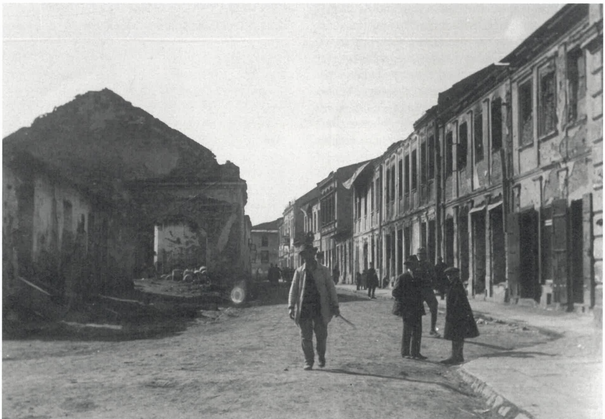
Gorlice. Fragment zniszczonej ulicy 3 Maja, maj 1915 roku [NAC]
