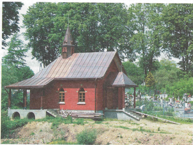
Budowa kaplicy cmentarnej w Turzy
