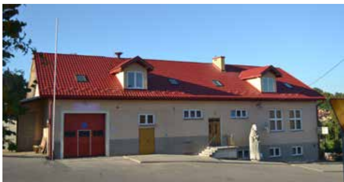
Trwa remont remizy OSP w Olszynach. Zakończyła się wymiana pokrycia dachowego.
