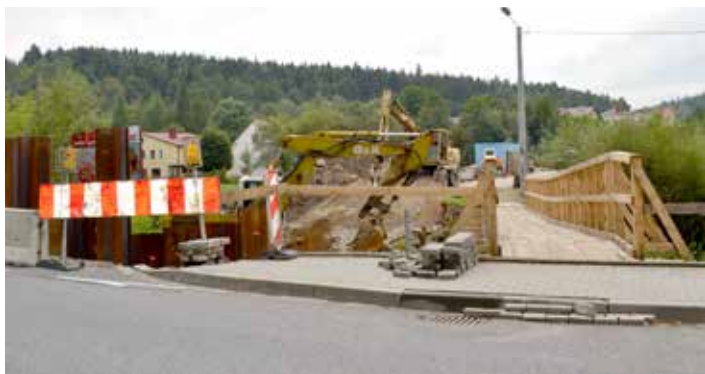
Z opóźnieniem rozpoczęły się prace remontowe przy budowie nowego mostu na drodze powiatowej w kierunku Turzy. Wprowadzono tymczasową zmianę organizacji ruchu. Do Turzy można dojechać przez Rożnowice lub Cieżkowice.
